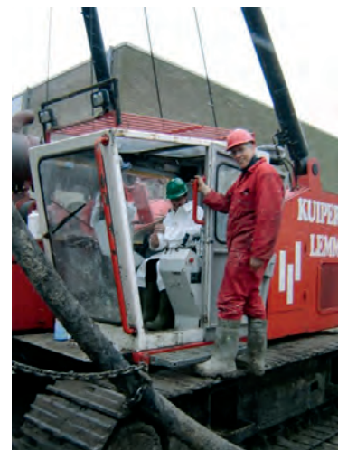
De eerste paal voor de nieuwbouw in Dokkum werd op 8 februari 2007 geslagen door wethouder T.Willemsma van Dongeradeel.
